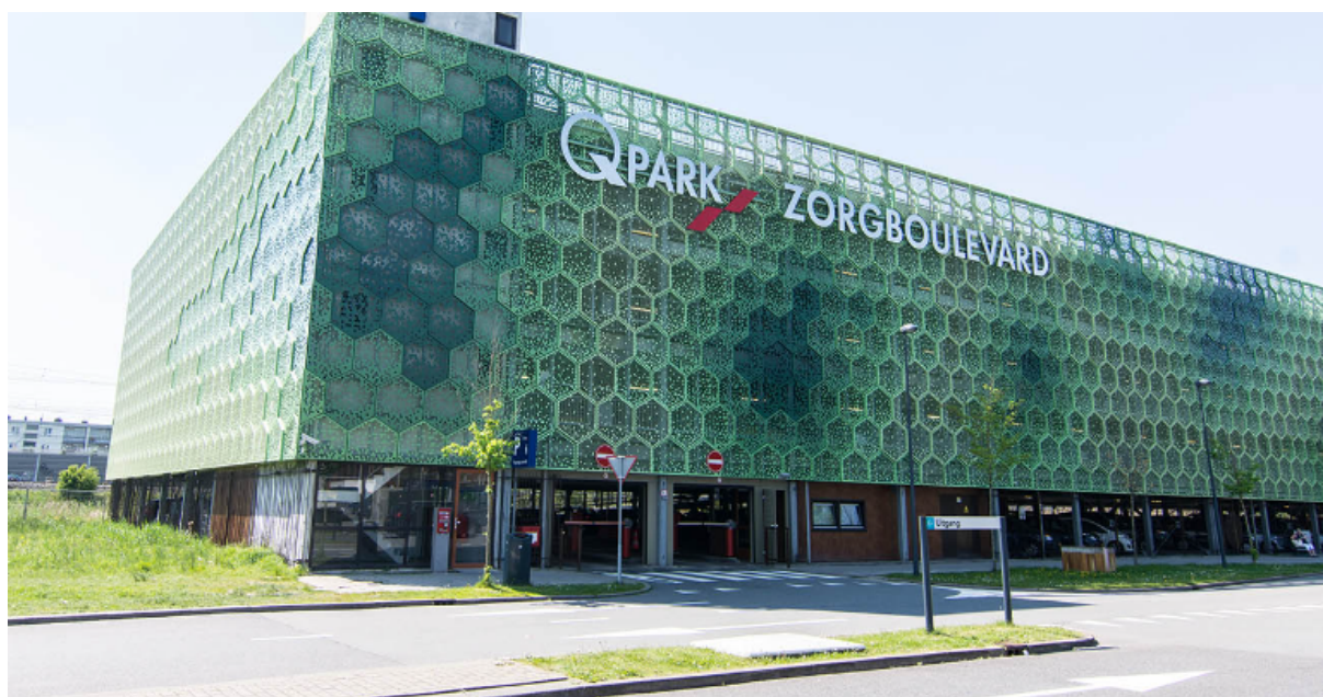
Q-Park Zorgboulevard, Rotterdam
